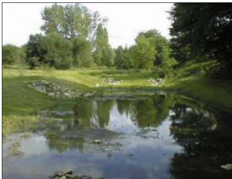
Figure 35 : Bassin paysager en eau
