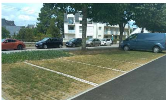
Fonction de stationnement + fonction hydraulique = parkings perméables
