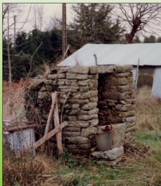
Puits à l'ancienne Maison Boulvais
